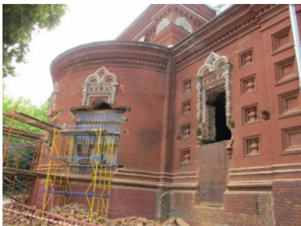
Освобождение оконных проемов
