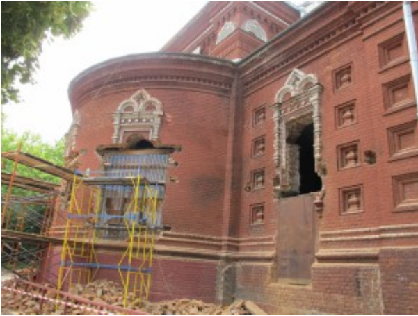
Освобождение оконных проемов
