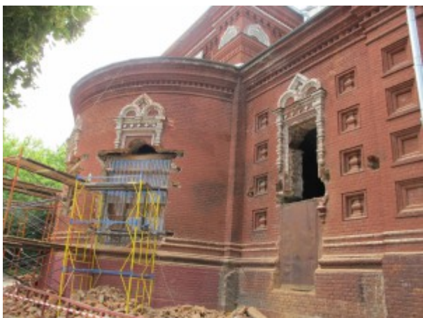
Освобождение оконных проемов
