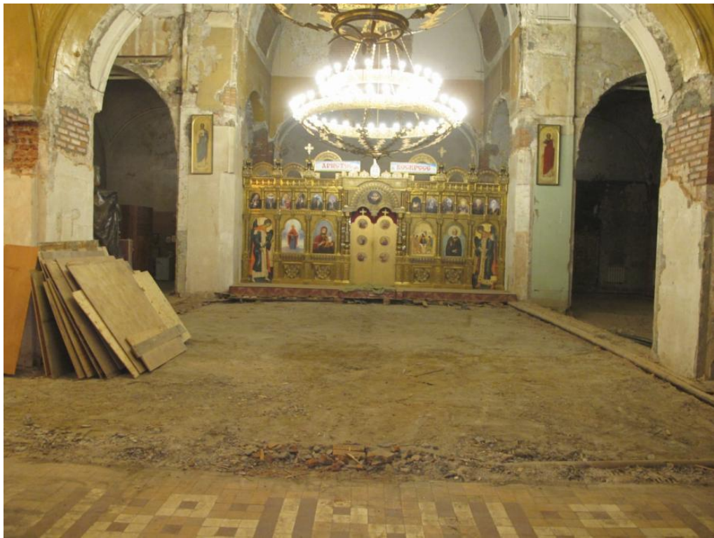
Демонтаж пола, 2015 год
