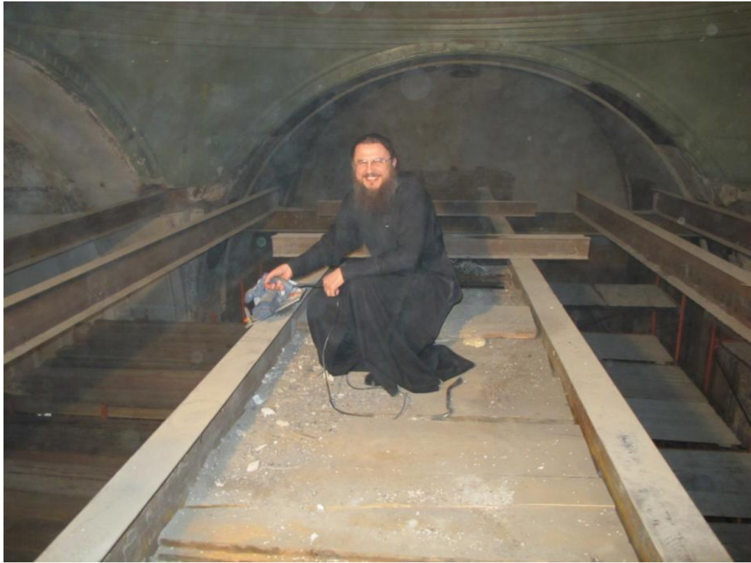
Демонтаж железных балок, 2015 год
